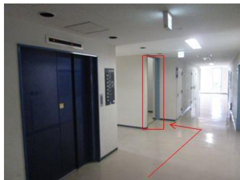
写真14 エレベーターと階段
