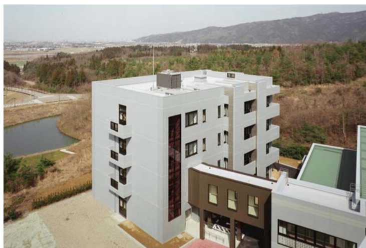
総合研究実験棟の建設
