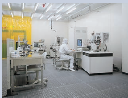
クリーンルーム
