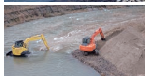
写真3：斐伊川において、土砂が枯渇する河川環境を改修するための「土砂還元」の様子
